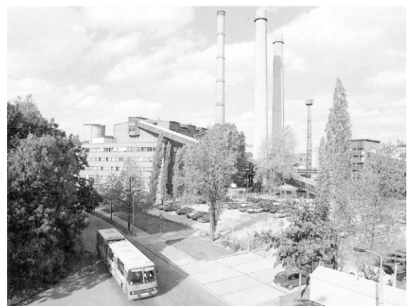
Heizkraftwerk Chemnitz Nord
